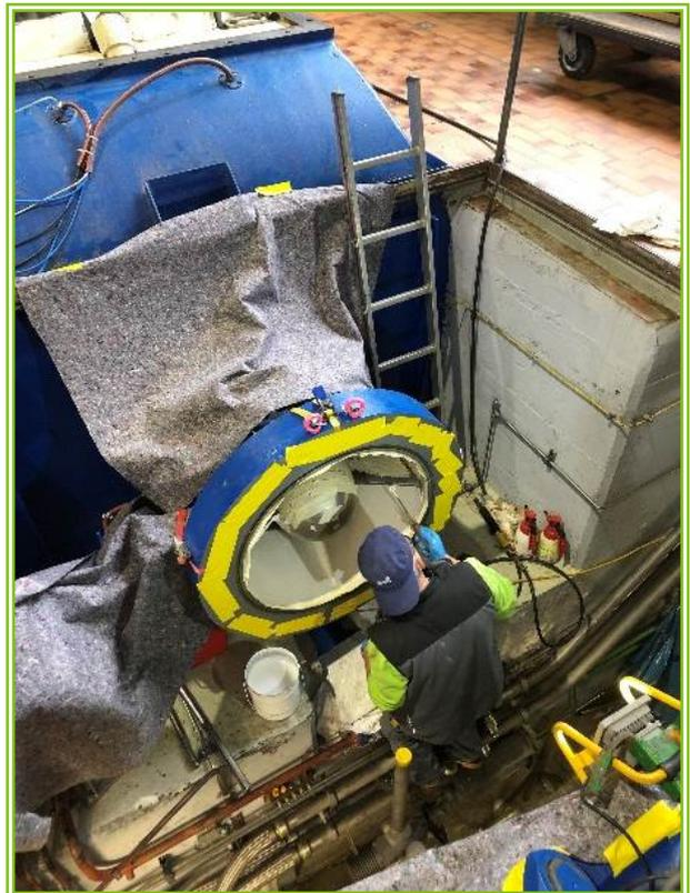
Korrosionsschutzarbeiten am Einlaufstern
