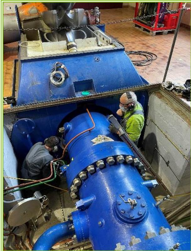
Einbau Zwischenrohr Maschinengruppe 3
