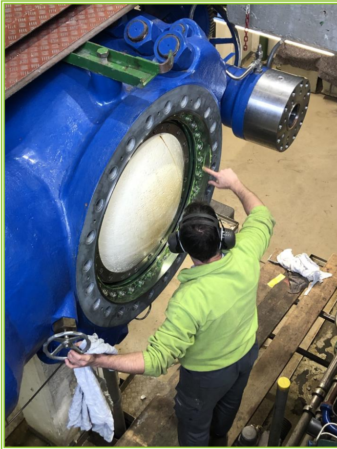
Montage neuer Betriebsstz Kugelschieber Maschinengruppe 3, Kraftwerk Mörel
