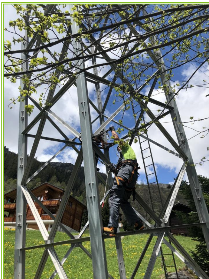
Schraubenkontrolle am Seilbahnmast
